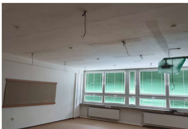
Výměna osvětlení kmenových tříd pavilonu B
